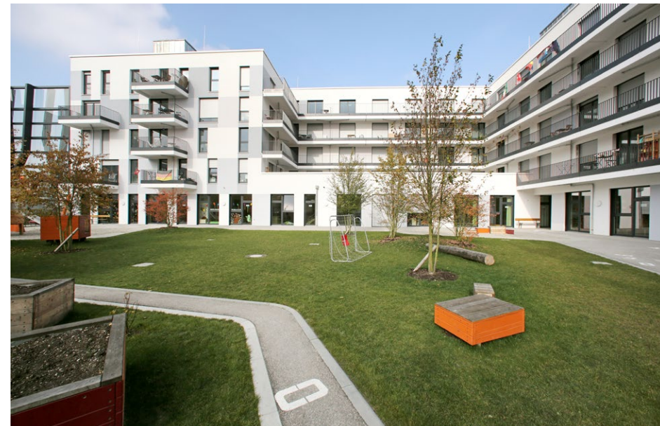
Die GEWOFAG baut für Studierende im DomagkPark 104 Appartements, 36 Einzelzimmer, vier rollstuhlgerechte Appartements.
